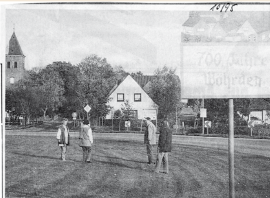
Das erste Projekt wird am Ortseingang in Angriff genommen
